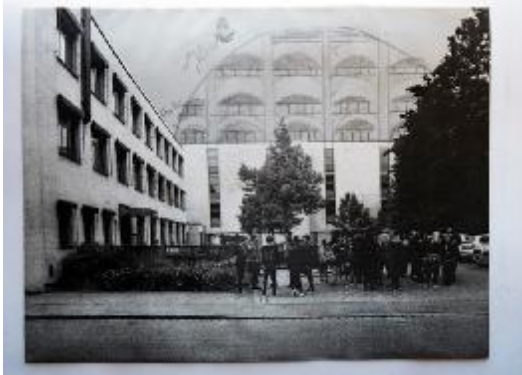
Der ausschnitthaft wirkende Dachaufbau orientiert sich sichtbar an den vertikalen Fensterachsen Abb. 18
